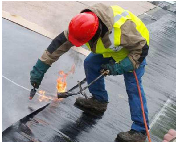
Figure 1 – Réalisation de soudures sur géomembranes bitumineuses par des opérateurs
