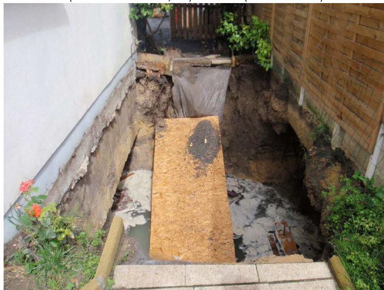
Photographie 1 : Fontis de 4 m de diamètre et 2 m de profondeur recensé dans l'enceinte du Bois de la Tussion (Seine-Saint-Denis, 93) en 2013 (Crédit INERIS)
