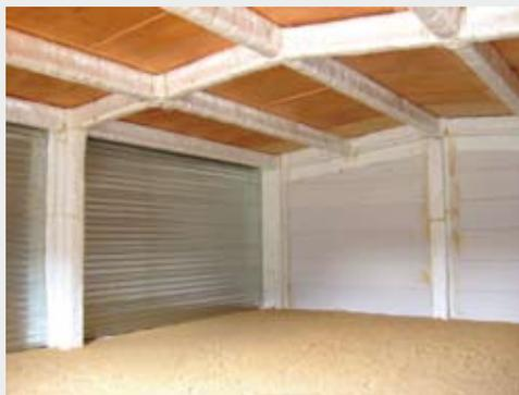
> Représentation schématique de la structure d'essais et photo montrant les parois (bardage et béton cellulaire ainsi que la structure protégée).
