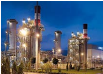
Centrale électrique de General Electric (Kemalpaşa, Turquie).
