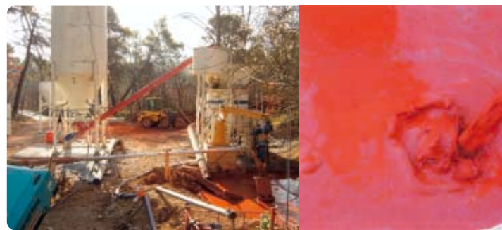
Différentes vues du plot de remblayage à l'aide d'un coulis à base de Bauxaline®.
