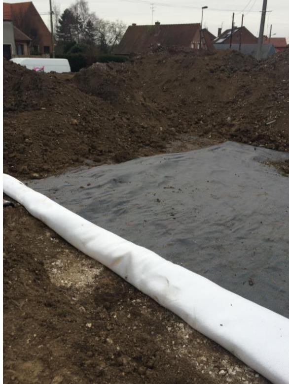
Figure 4. Mise en place du géosynthétique, avancement bande par bande.
