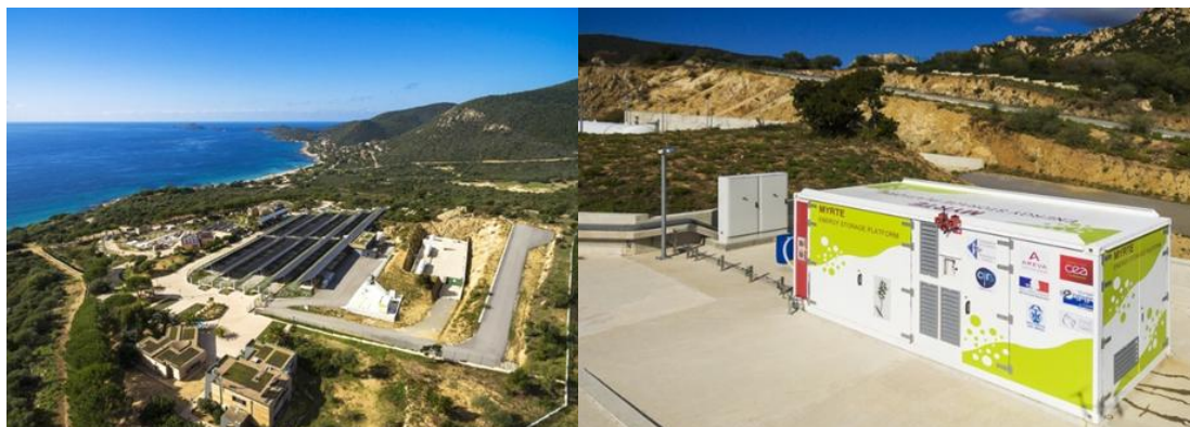
Figure 2. La plateforme MYRTE à Ajaccio, France et la Greenergy Box installée sur cette plateforme
