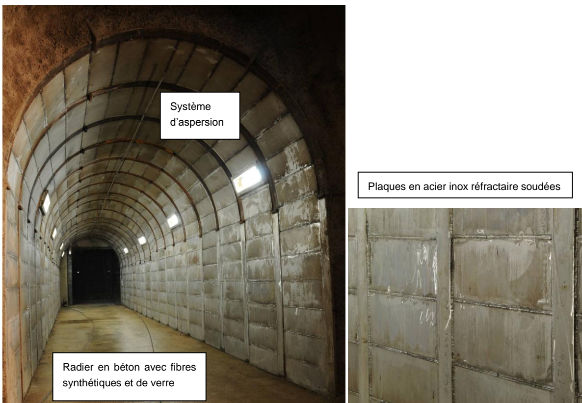
Figure 4 : Vue de la zone d'essais renforcée par plaques d'acier
