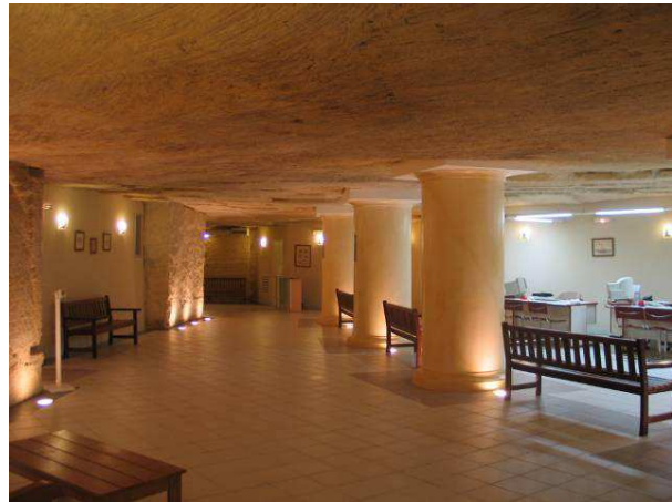
Photo 5 : "Remplacement" d'anciens confortements par des piliers en béton, intégrés à l'architecture du centre thermal
