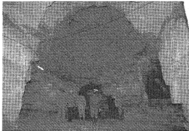
Figure 11. Cloche de fontis dans une carrière de calcaire grossier des environs de Paris.
