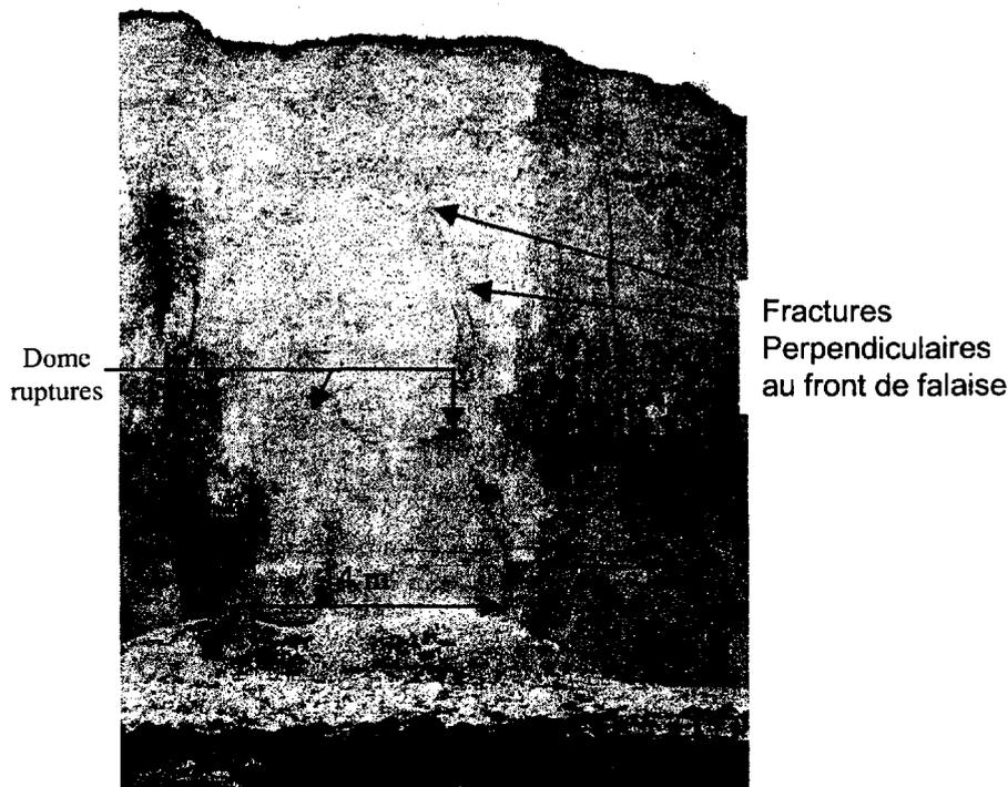
Figure 7 : Eboulement du 23 juin ayant affecté le centre de la zone instrumentée. Le volume de matériau éboulé est d'environ 2000 m<sup>3</sup>.
