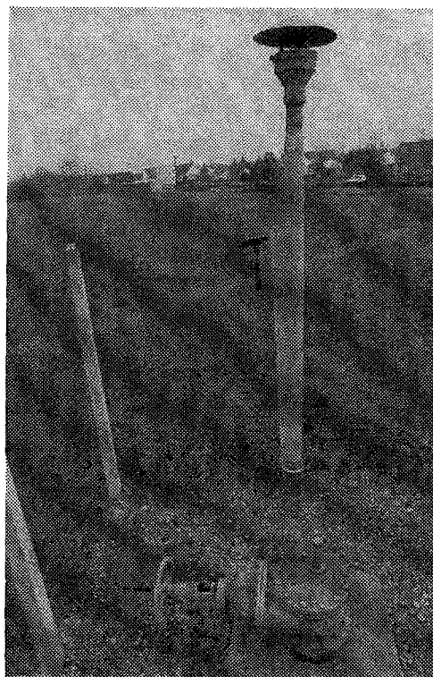
Figure 4 : Vue de l'équipement de principe d'un sondage de décompression et photographie d'un tel sondage installé dans le bassin de Blanzky-Montceau
