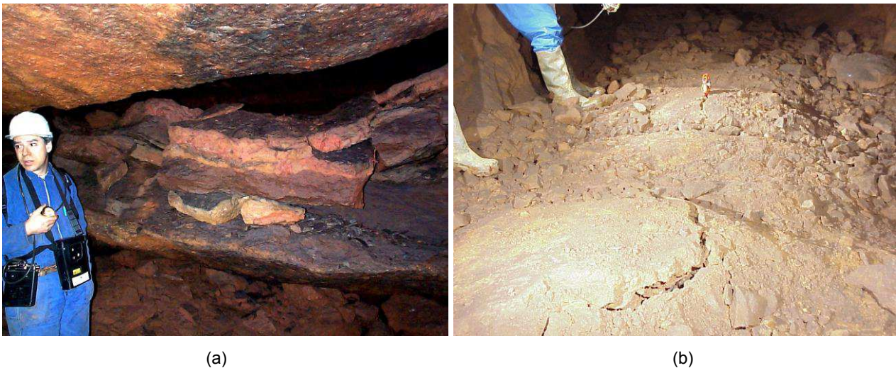
Figure 7 – Stot de Nondkeil (Ottange) - Exemple de dégradations observées dans la couche jaune sauvage. (a) chute d'intercalaire, (b) fissure de soufflage au mur
