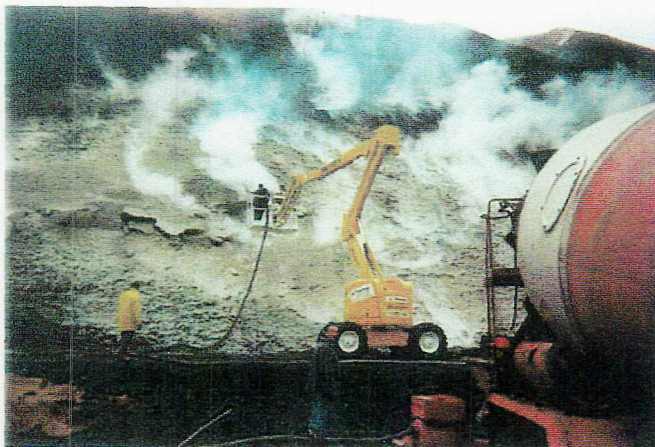
Figures 5 et 6 : Projection de béton projeté pour étancher rapidement les secteurs en échauffement.
