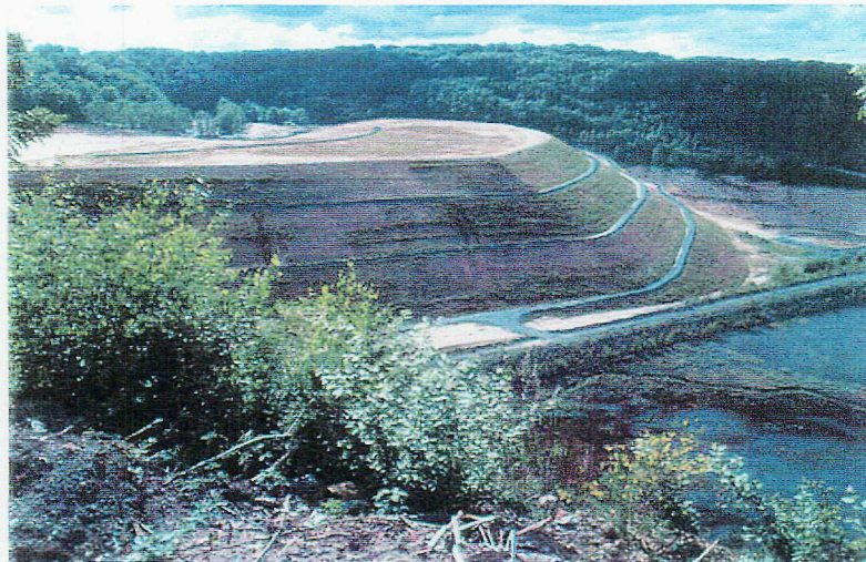
Figure 11 : Vue finale du schistier avec ses 3 banquettes drainantes (mai 2002).
