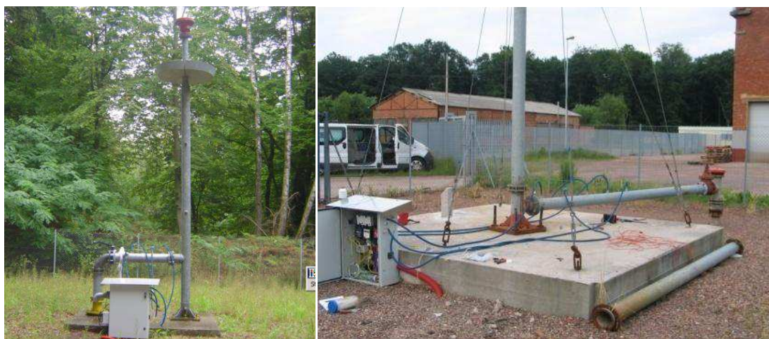
Figure 5 : Instrumentation du sondage SDEC OUEST 1 (g.) et du puits Barrois (d.)
