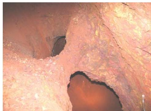
Figure 7 : Dégradation d'un pilier dans une exploitation pentée à May-sur-Orne (14)
