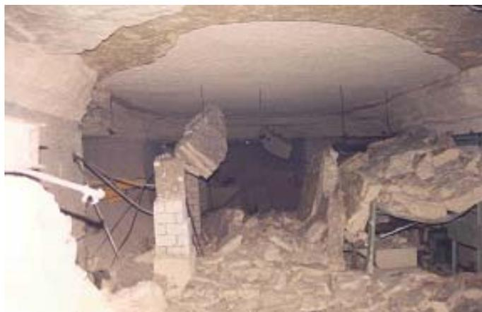
Figure 1 : Exemple d'éboulement du premier banc de toit dans une carrière de calcaire.
